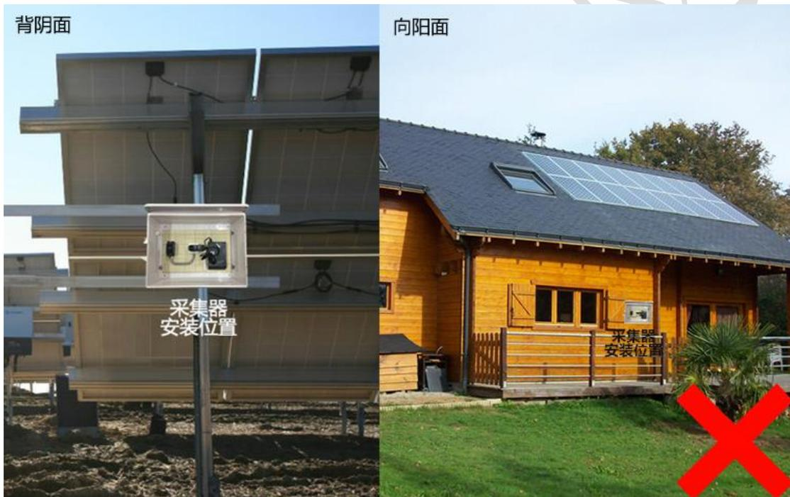
注意三：2G/3G 光伏数据采集器属于无线通讯设备，不允许安装在变压器、高压线等具有强磁场的设备附近，要求安装时离变压器设备至少 2 米，离逆变器至少 1 米距离，如下图：
